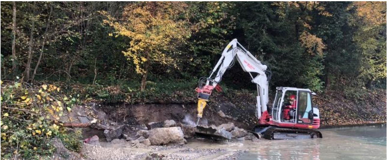
Abbildung 4: Entfernen der letzten Betonplatten
