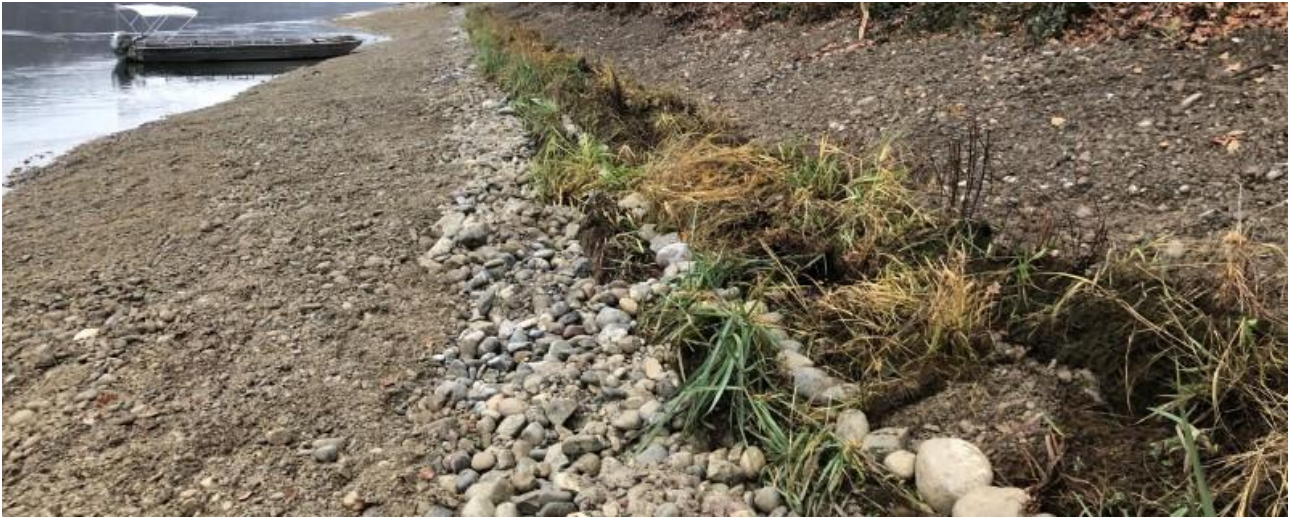
Abbildung 5: Grünverbau mit Röhrichtfaschinen und Röhrichtmatten
