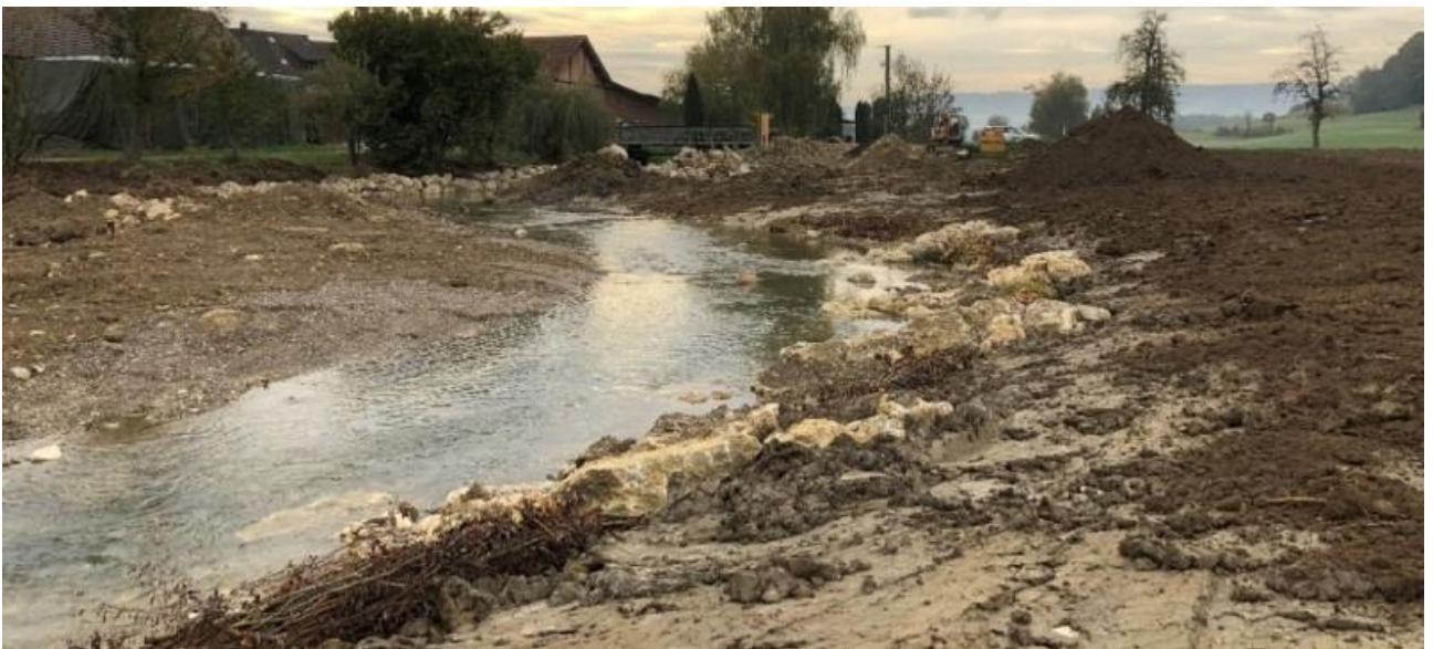
Abbildung 8: Verbreiteter Gewässerraum, Ufer mit Faschinen
