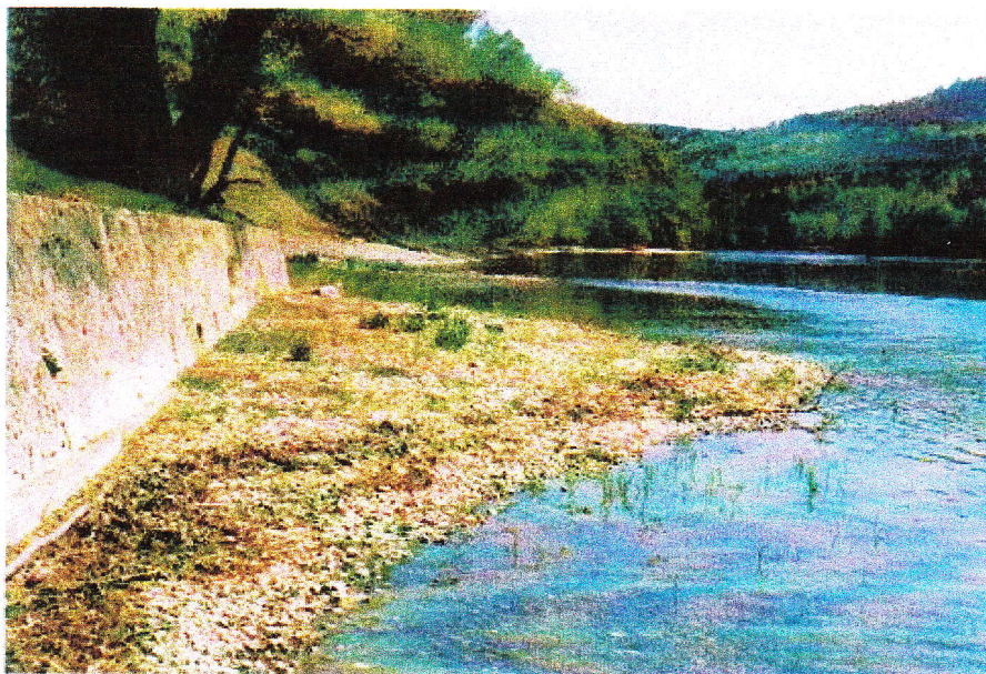
Foto 11: Uferverbauung bei der Mühle Obergailingen: Die natürliche Kiesbank wird bei Hochwasser überflutet, der Pegel erreicht das Mauerwerk - zum Nachteil der Äschenlarven.
