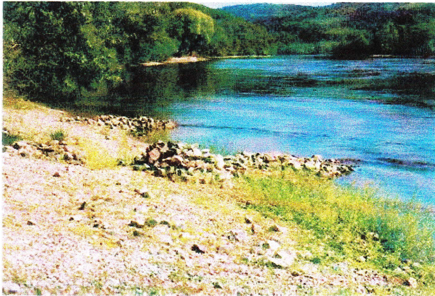
Foto 7: Kiesschüttung mit Störsteinen und Bühnen aus Porphy ca. 400 m unterhalb der Kapelle St. Nikolaus in Obergailingen
